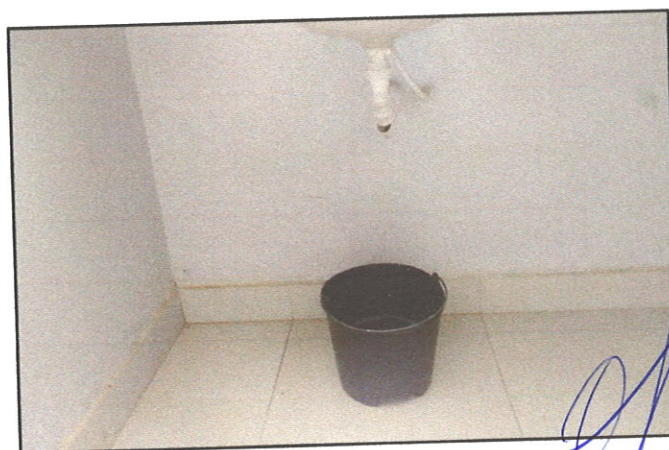
FIGURA 06 - Sifão danificado
